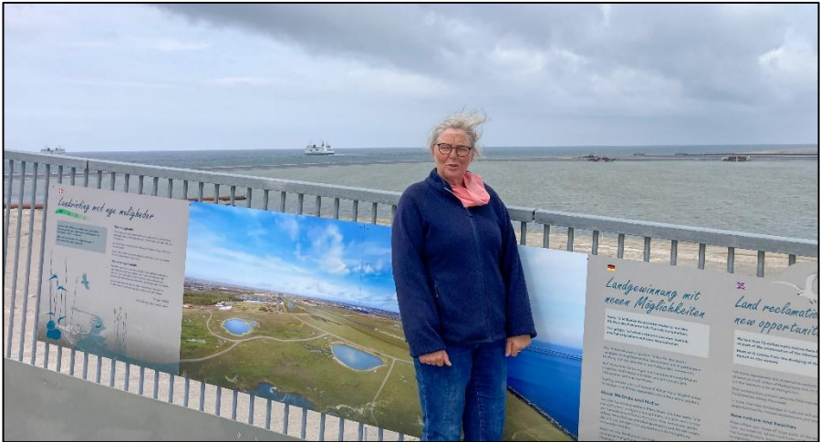
Auf der Baustelle zum Belttunnel.
