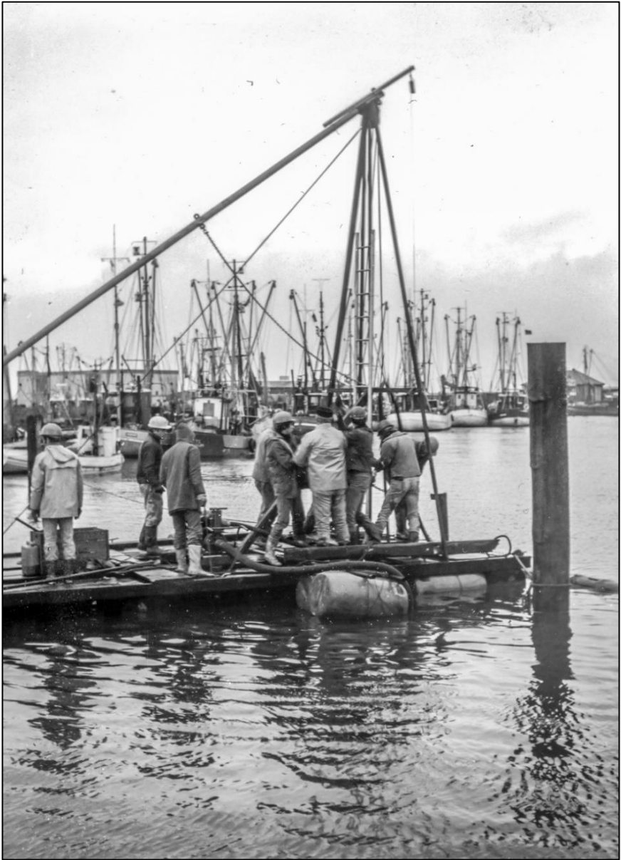
Solche Fotos fehlen im Archiv: Etwa 1975 spülen wir neue Heckpfähle ein. Das Floss ist aus Schwimmstegen zusammengebaut. Personen (v.l.n.r.): Lone Ortmann, Horst Krause, Jörg Becker, Jonny Nickelsen (verdeckt), Kai Bruhn, Uwe Paulsen, NN, Jörgen Bruhn, NN. (Foto: Ove Ketels/ Slg. Jörgen Bruhn).
