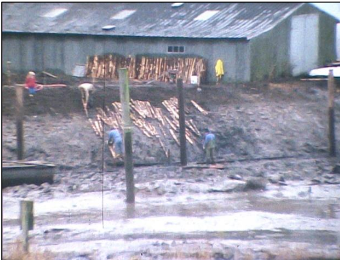
Pfähle für die Fussicherung.
