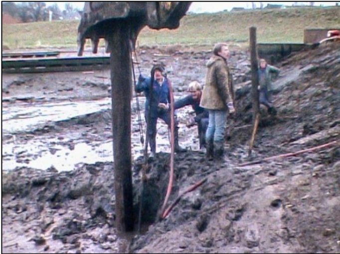
Mit dem Bagger werden die Dalben eingespült (Günter Hirschbeck, Fred Lorenzen, Jörgen Bruhn, Otto Jebe).
