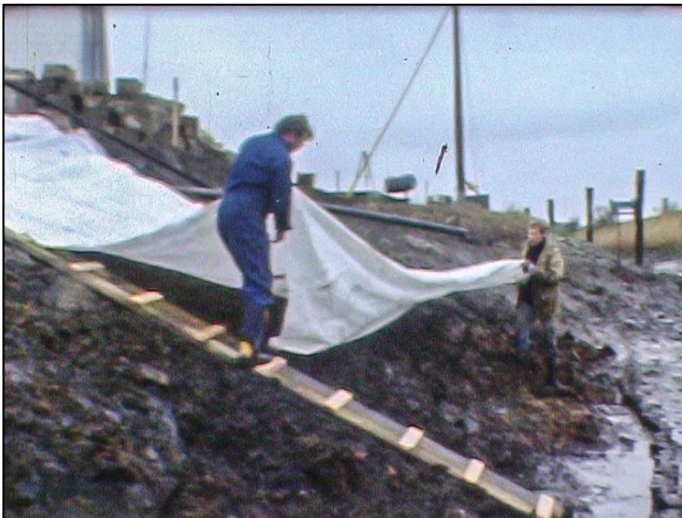
Die erste Vliesbahn wird ausgebreitet; wir sind gespannt, ob alles funktioniert. (Christian Clausen, Jörgen Bruhn).
