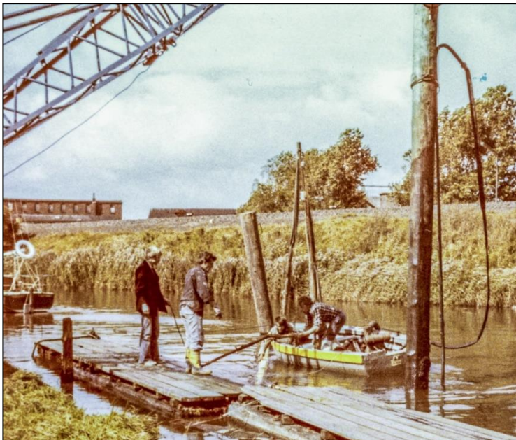
Interimslösung: Mit dem Demag-Kran vom Hafenamt werden Pfähle für die Holz-Schwimmer eingespült (Personen: Christoph Voigts, Takelmeister Günter Hirschbeck, Jürgen Ketels, Jörgen Bruhn). (Foto: Archiv HSrV).
