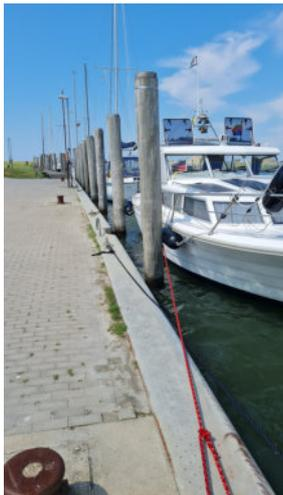
Die Durchfahrt durch das ca. 5m breite Deichschart stellte bei dem Wasserstand kein Problem dar. Bei halber Tide ist dort schon mit starker Strömung zu rechnen. Da hier mit ca. 2,5m Tidenhub zu rechnen ist, und Festmacherpfähle direkt vor der Spundwand stehen, müssen wir mit Langleine festmachen und die Fender querhängen.
