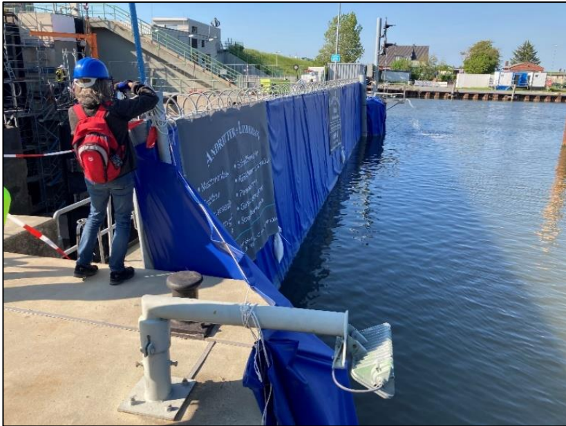
Abdichtung durch Plane (Foto: Hargen Johannsen).
