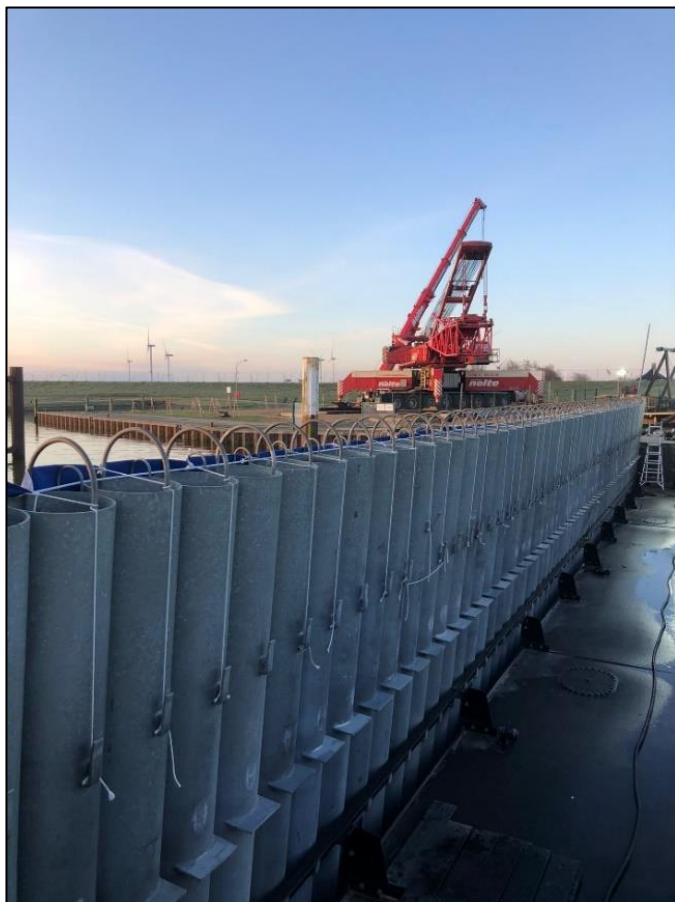
Wand aus Rohrnadeln (Foto: Martina Nieder)
