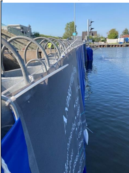
Detail Rohrnadelwand (Foto: Hargen Johannsen)
