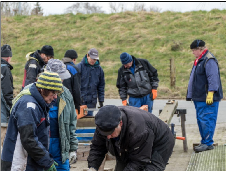
Brückenreparatur Winter 2019: „all hands!“ (Foto: Jörgen Bruhn)
