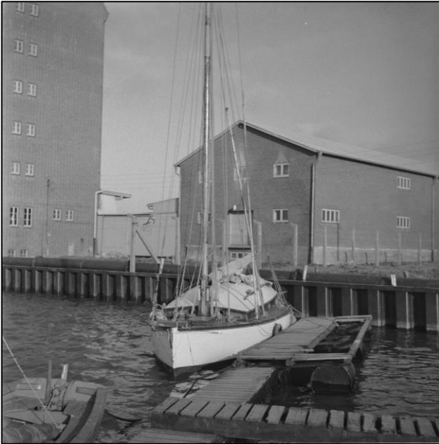
„Cimber II“ am Thordsen-Silo
