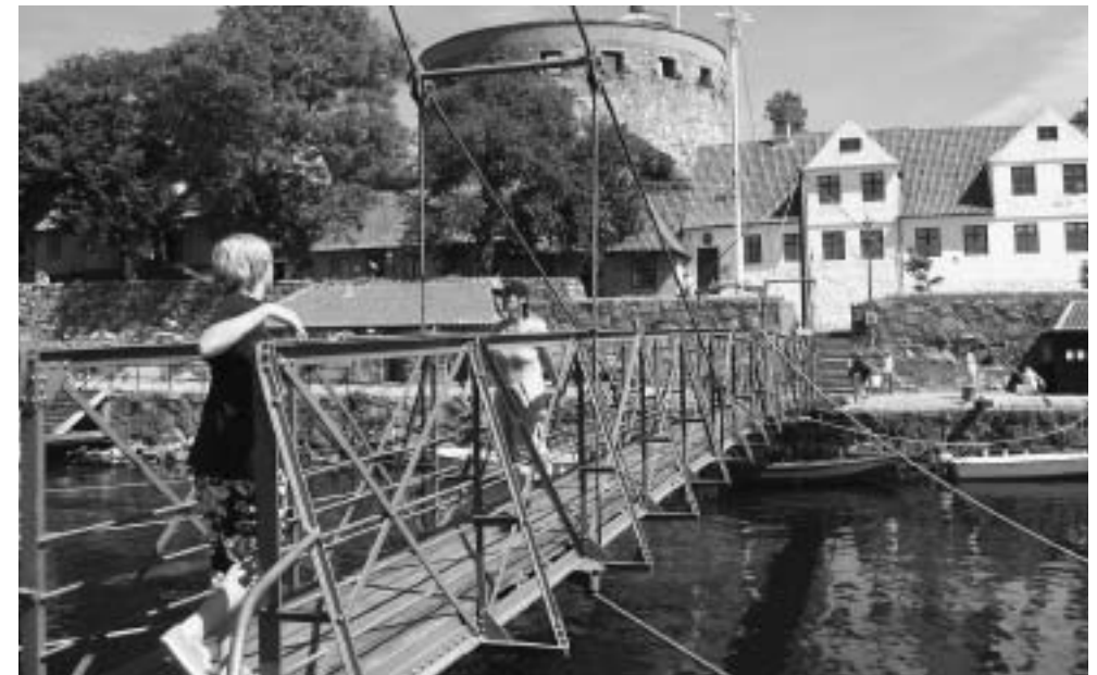
Fußgänger-Drehbrücke auf Christiansö
