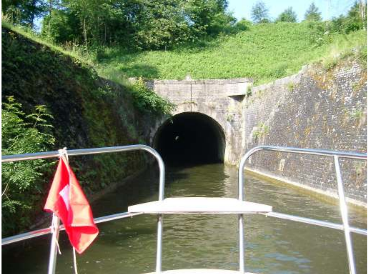
Einfahrt in den Tunnel von Givet
